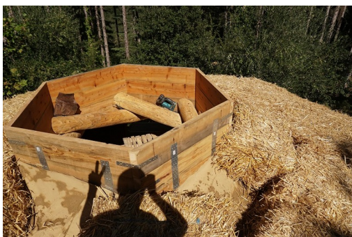
Bottes de paille sur géotextile barbotiné
