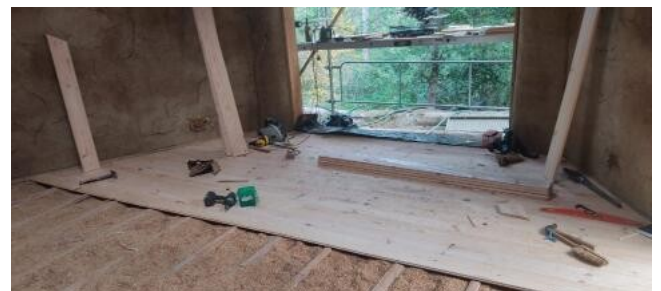
balle de riz en isolant dans les palettes
