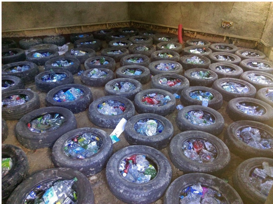
pneus remplis de bouteilles plastiques
