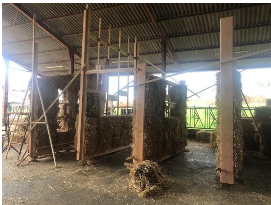
Organisation préfabrication murs
