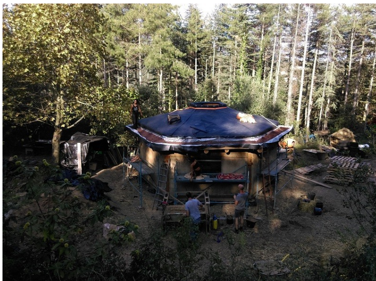
Pose EPDM et pouzzolane en débord de toiture
